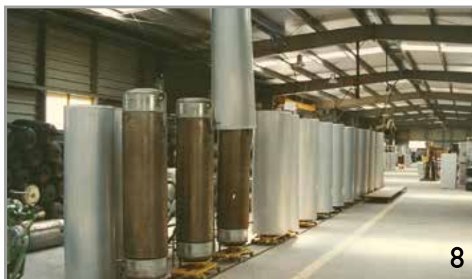
8. Συναρμολόγηση δοχείων / Assembly of storage tanks
